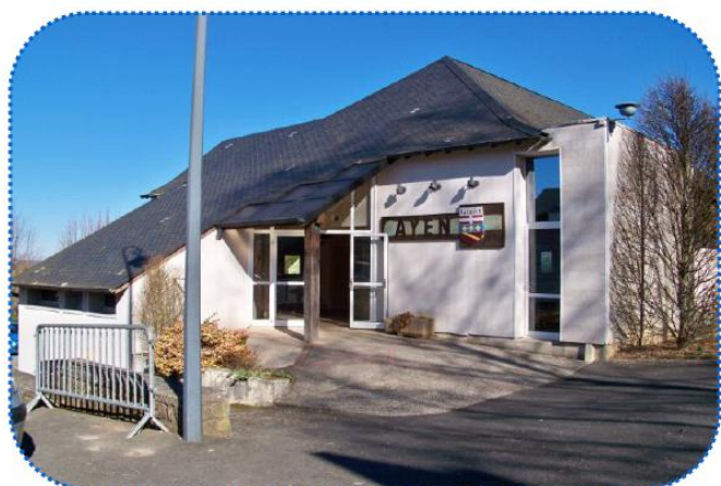
Rénovation thermique de la salle des fêtes
