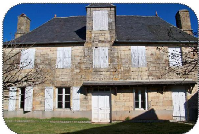
Rénovation thermique du Presbytère
