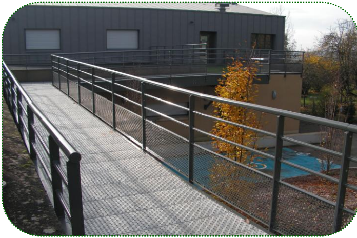
Bâtiment périscolaire Halte garderie – CLSH – Salle de sport
